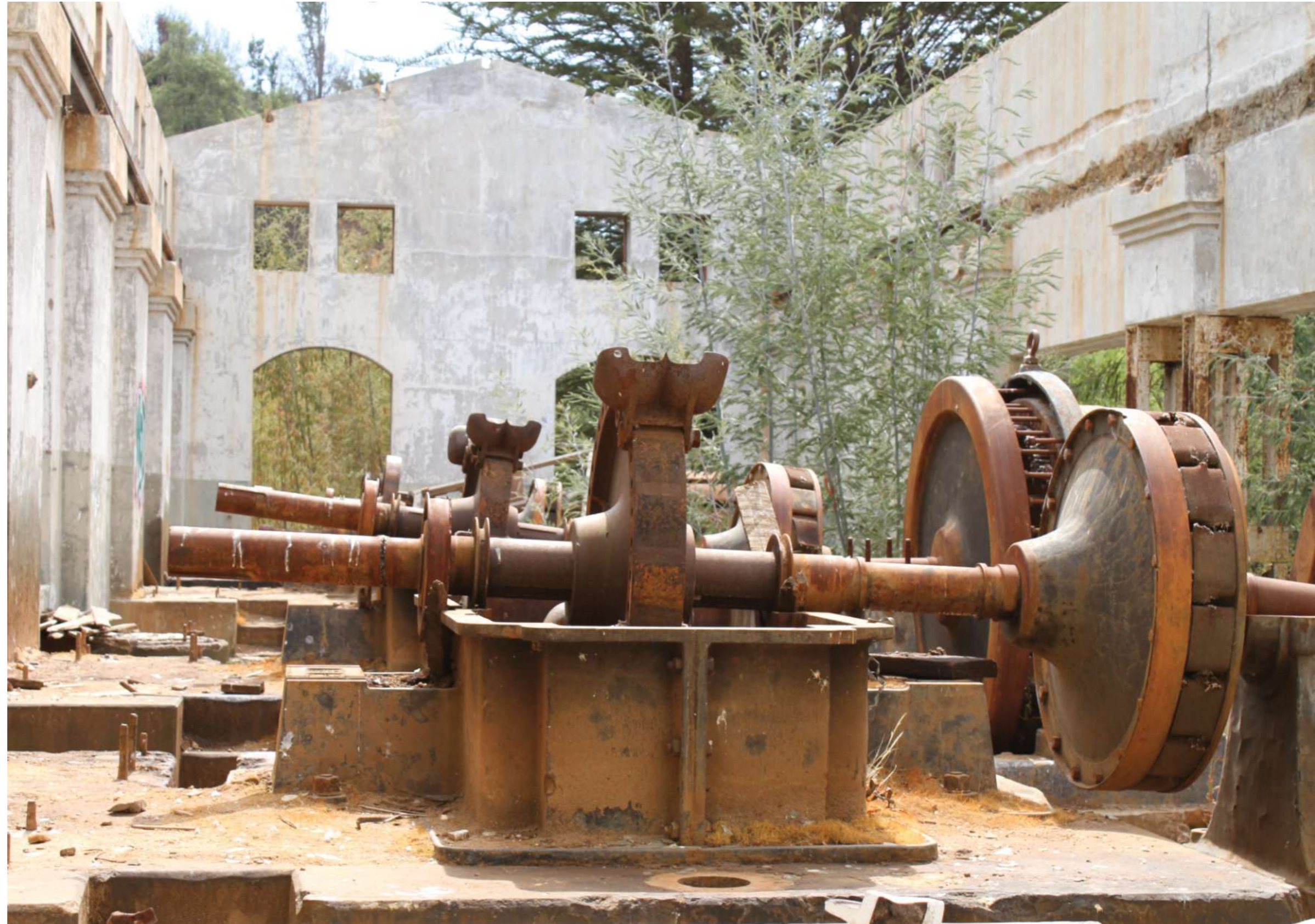
Vista de la sala de máquinas El Sauce en la actualidad
